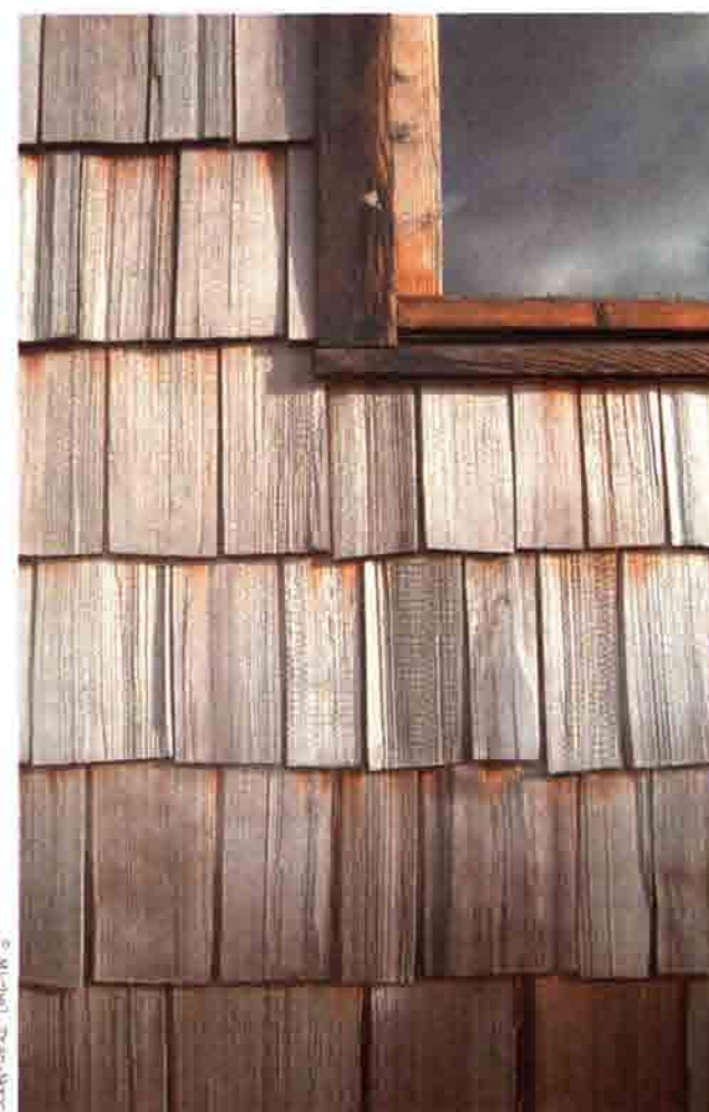
Détail de la couverture en bardeaux.
