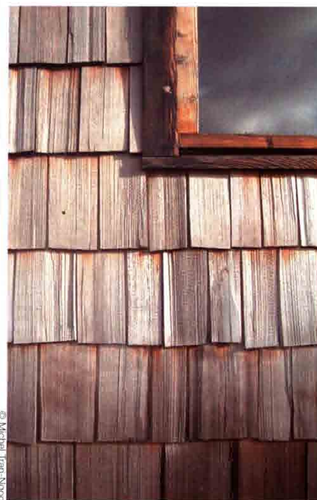
Détail de la couverture en bardeaux.
